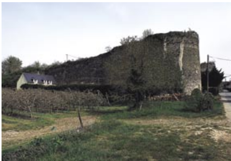
L'usine de chaux du Petit-Lapin comprend deux fours construits en 1840 et 1845. La rampe de chargement du four sud est conservée.
