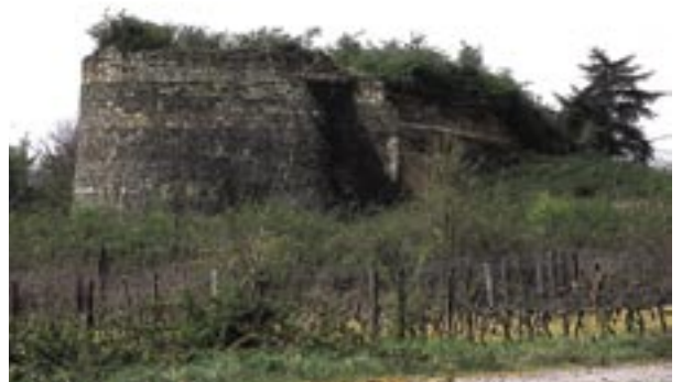
Le four de Montpellier, ou de Grand-Lièvre, a été construit à la fin du XVIII e siècle ou au début du suivant. À droite, on aperçoit les vestiges de sa rampe qui permettait de charger le charbon et la pierre par le haut du four.
