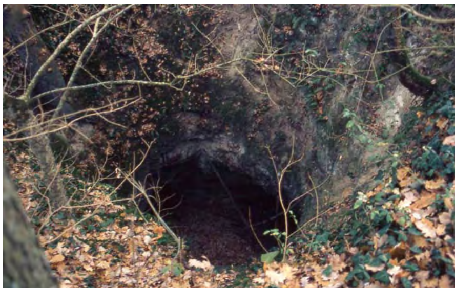
Figure 60 : Quelques exemples d'entrées dangereuses
